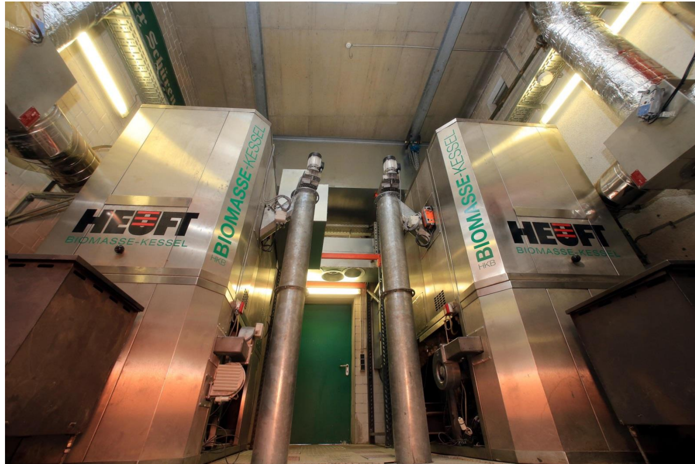
Biomasse-Kesselanlage
