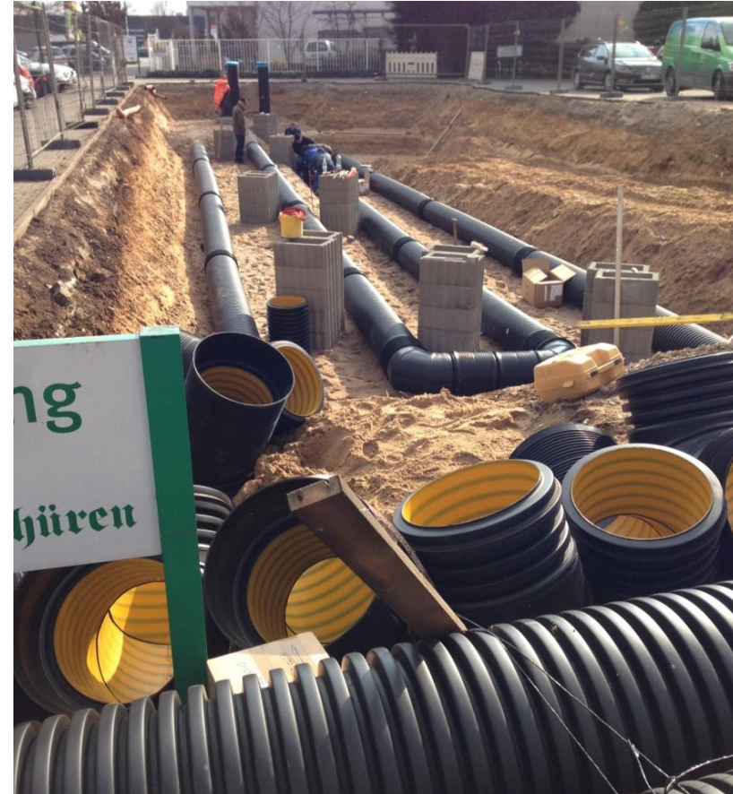
Erdwärmetauscher-Rohre
