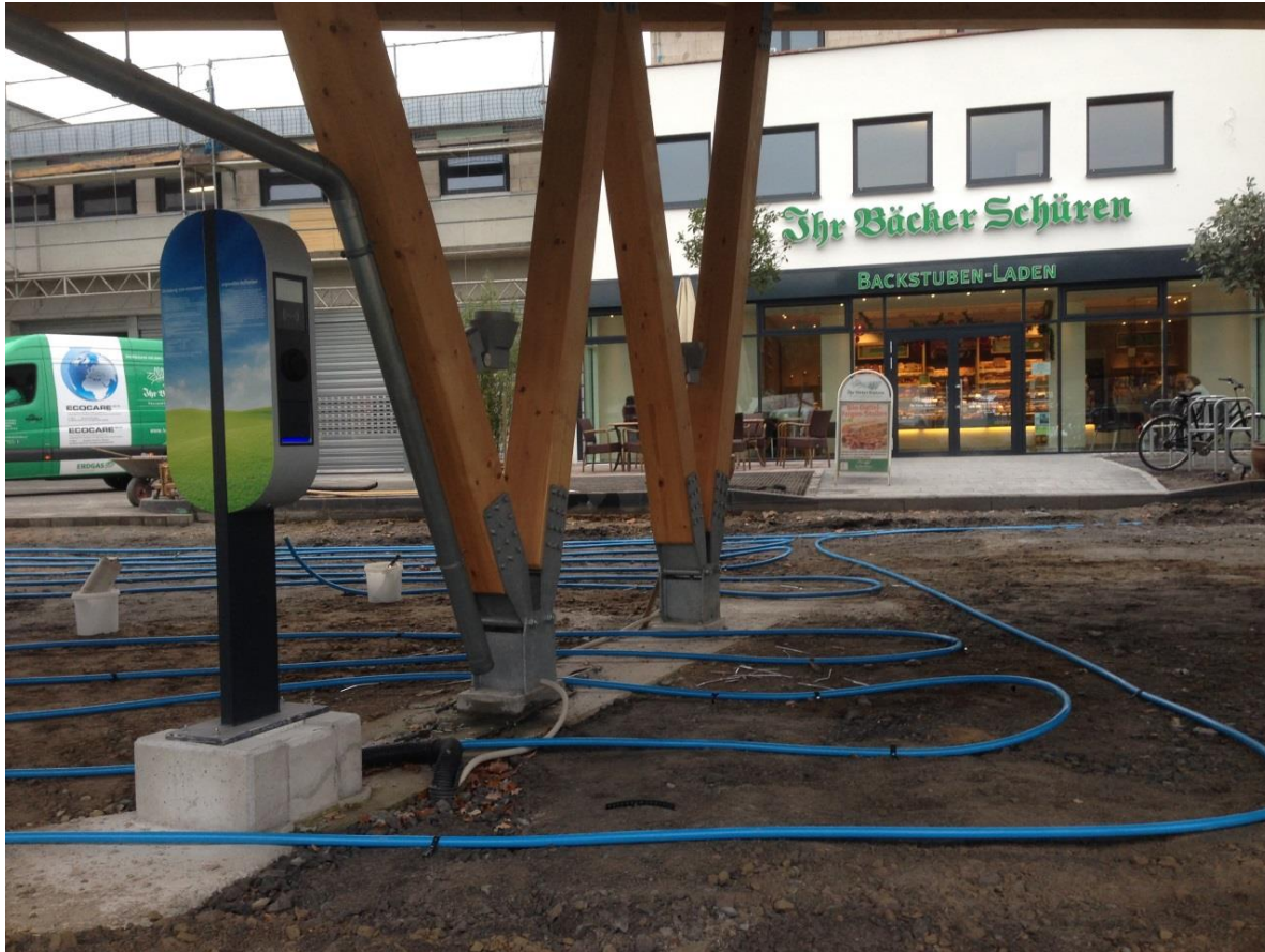
„Freiflächenheizung“ = Betrieb in der kälteren Jahreszeit
